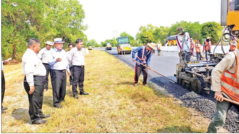
ယင်းနောက် ဒုတိယဝန်ကြီးနှင့်အဖွဲ့သည် ရန်ကုန်-မန္တလေးအမြန်လမ်းမ မိုင်တိုင်အမှတ် (၄၅/၂) နှင့် (၄၅/၃)အကြားရှိကြတ်ချောင်းလက်တက်တံတား ချဉ်းကပ်လမ်း ကျောက်စီခြင်း၊ မြေဖိုခြင်းနှင့် Gabion Wall ဖြင့် မြေထိန်းနံရံတည်ဆောက်ခြင်းလုပ်ငန်း ဆောင်ရွက်နေမှုနှင့် မိုင်တိုင်အမှတ်(၁၃/၀) မှ (၁၄/၀)
