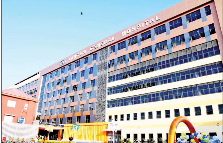
ရန်ကုန်ပြည်သူ့ဆေးရုံကြီး ခုနစ်ထပ် ကုသဆောင်သစ်အဆောက်အအုံကို တွေ့ရစဉ်။
