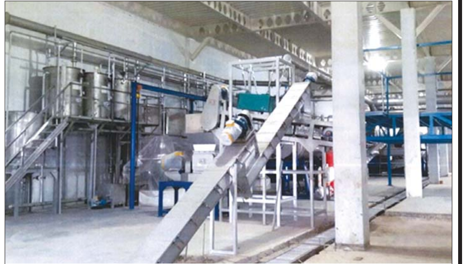
ပန်းတနော်ရေနက်ကွင်းတွင် GEAAI က တည်ဆောက်နေသည့် ငါးအစာတောင့်စက်ရုံကို တွေ့ရစဉ်။
