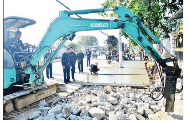
နောက်ဆုံးစွန့်ပစ်အမှိုက်ပုံ (Final Disposal Site-FDS) တည်ဆောက် ရေးစီမံကိန်းလုပ်ငန်း ဆောင်ရွက်နေမှုများကို လိုက်လံကြည့်ရှု စစ်ဆေးပြီး လိုအပ်သည်များ ဖြည့်ဆည်းဆောင်ရွက်ပေးခဲ့ကြောင်း သိရသည်။
