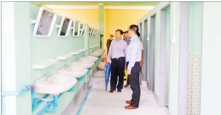
ထိုသို့ကြည့်ရှုစစ်ဆေးရာတွင် ပြည်နယ်ဝန်ကြီးချုပ်က လှိုင်ကော်မြို့ ပညာရေးဒီဂရီကောလိပ် ကျောင်းဝင်းအတွင်း၌ ကျောင်းသားအိပ်ဆောင်သစ် တည်ဆောက်နေမှုနှင့် စားရိပ်သာများ ပြင်ဆင်
