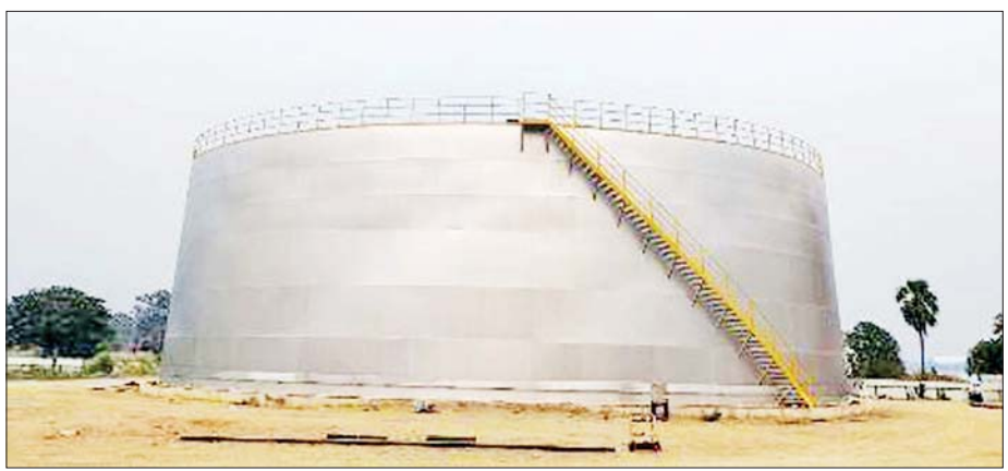
စစ်ကိုင်းတိုင်းဒေသကြီးအတွင်း အကောင်အထည်ဖော်နေသည့် အီသနောတန်ချိန်ငါးသောင်းထွက် စက်ရုံစီမံကိန်းမှ တင်လဲရည်ကန်ကြီး တည်ဆောက်ပြီးစီးနေမှုကို တွေ့ရစဉ်။
