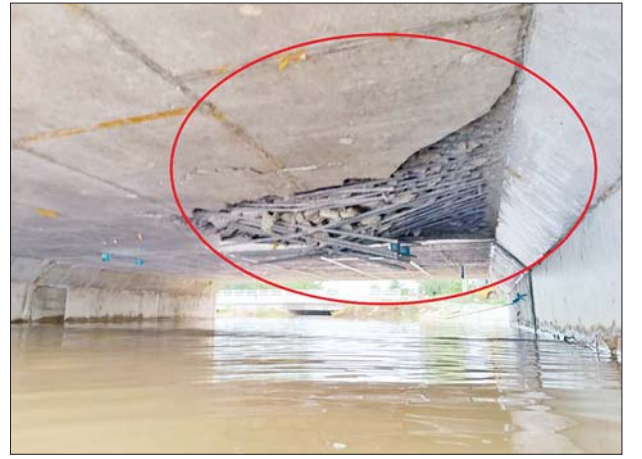
ရထားလမ်းတံတားအမှတ် (၁၆၁) ကွန်ကရစ်ကြမ်းခင်း Slap အောက်ခံမျက်နှာပြင် ကွာကျထိခိုက်ပျက်စီးမှုကို တွေ့ရစဉ်။
