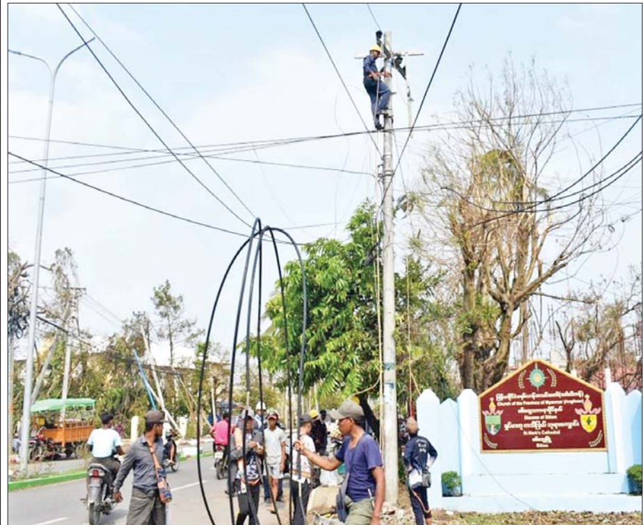
စစ်တွေမြို့တွင်းဓာတ်အားလိုင်း၊ ထရန်စဖော်မာနှင့် အဆောက်အအုံ ပြန်လည်ပြုပြင်ဆောင်ရွက်နေစဉ်။
