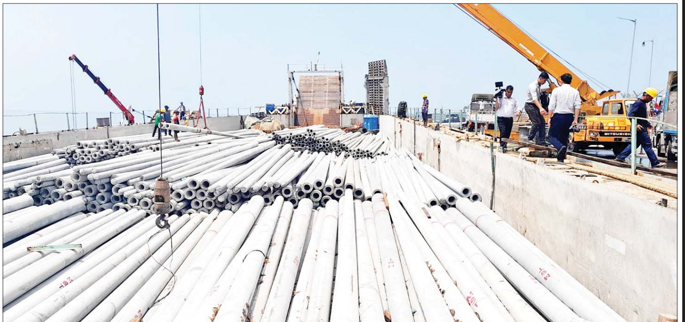
ပို့လွှတ်ရေးဓာတ်အားလှိုင်းနှင့် ဖြန့်ဖြူးရေးဓာတ်အားလှိုင်းများအတွက် လိုအပ်သောကွန်ကရစ်တိုင်များအား ရေယာဉ်များဖြင့် သယ်ယူပို့ဆောင်ပေးနေသည်ကို တွေ့ရစဉ်။
