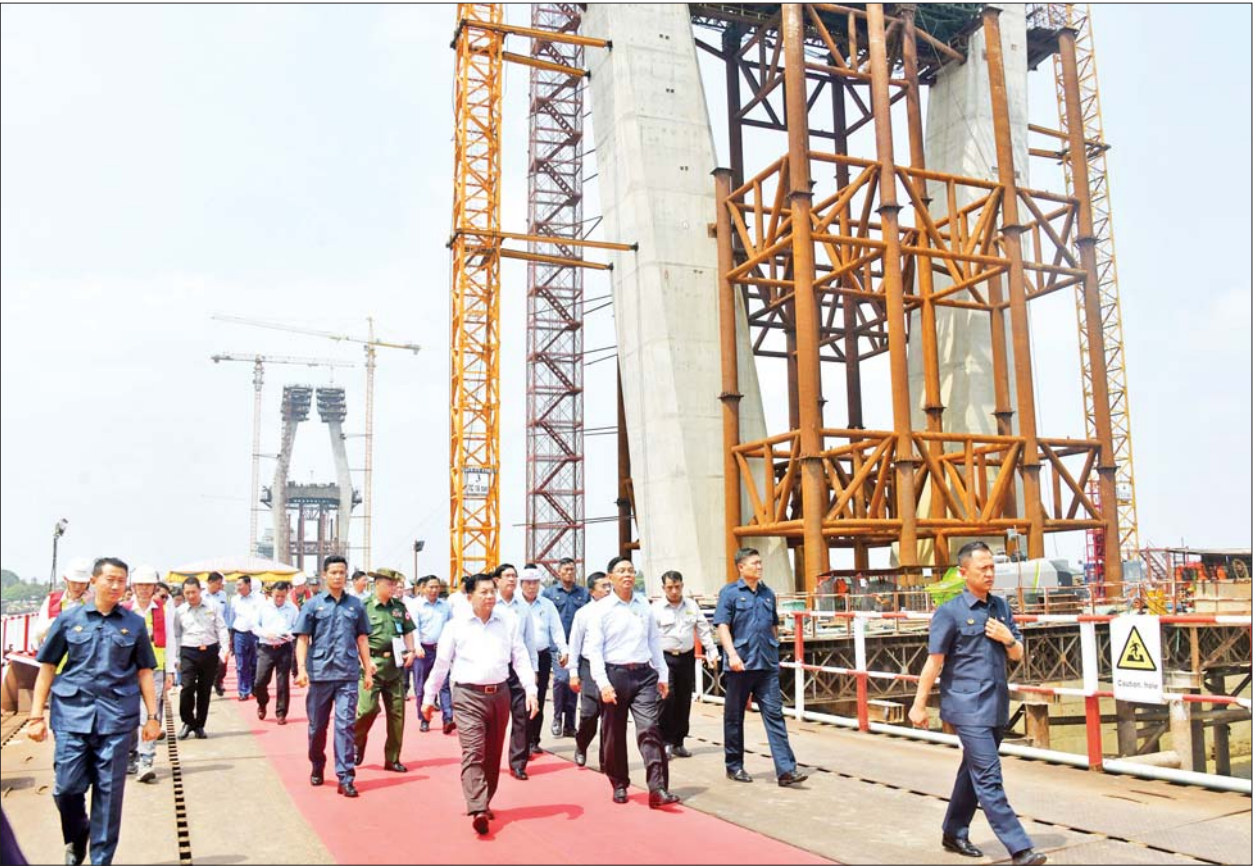
နိုင်ငံတော်စီမံအုပ်ချုပ်ရေးကောင်စီဥက္ကဋ္ဌ နိုင်ငံတော်ဝန်ကြီးချုပ် ဗိုလ်ချုပ်မှူးကြီး မင်းအောင်လှိုင် မြန်မာ-ကိုရီးယား ချစ်ကြည်ရေး (ဒလ) တံတားစီမံကိန်းရှိ ရန်ကုန်ဘက်ခြမ်း Main Bridge Pylon ၂ နေရာတွင် လုပ်ငန်းဆောင်ရွက်နေမှု အခြေအနေများကို ကြည့်ရှုစစ်ဆေးစဉ်။
