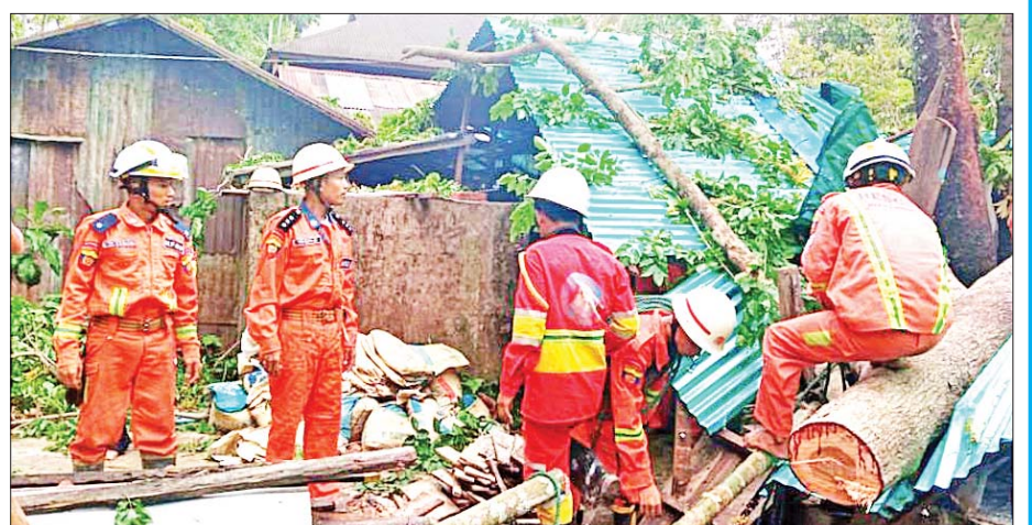
ငါးခယ်မမြို့နယ် ဆေးရုံရပ်ကွက် မဟာဝိသုတာရာမကျောင်းဝင်းအတွင်း၌ မေ ၁၄ ရက်က လေပြင်းတိုက်ခတ်မှုကြောင့် သစ်ပင်များ ပြိုလဲပျက်စီးမှုများကို မြို့နယ်သဘာဝဘေးကော်မတီက ရှင်းလင်းဆောင်ရွက်ပေးစဉ်။ မြို့နယ်(ပြန်/ဆက်)
