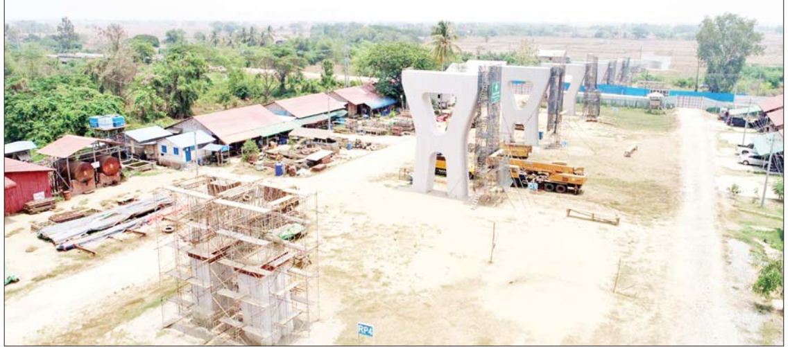
ဒလမြို့နယ်ဘက်ခြမ်းရှိ Pier တိုင် တည်ဆောက်ခြင်းလုပ်ငန်းများ ဆောင်ရွက်ပြီးစီးမှုကို တွေ့ရစဉ်။
