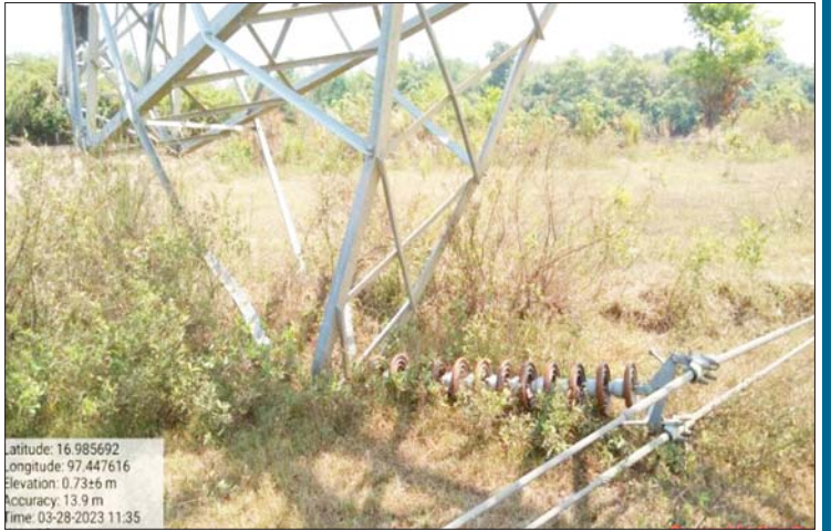
၂၃၀ ကေစီ သထုံ - မော်လမြိုင် ဓာတ်အားလိုင်း တာဝါတိုင်တစ်တိုင် မိုင်းခွဲဖျက်ဆီးခံရ၍ ပြိုလဲပျက်စီးနေပုံ။
