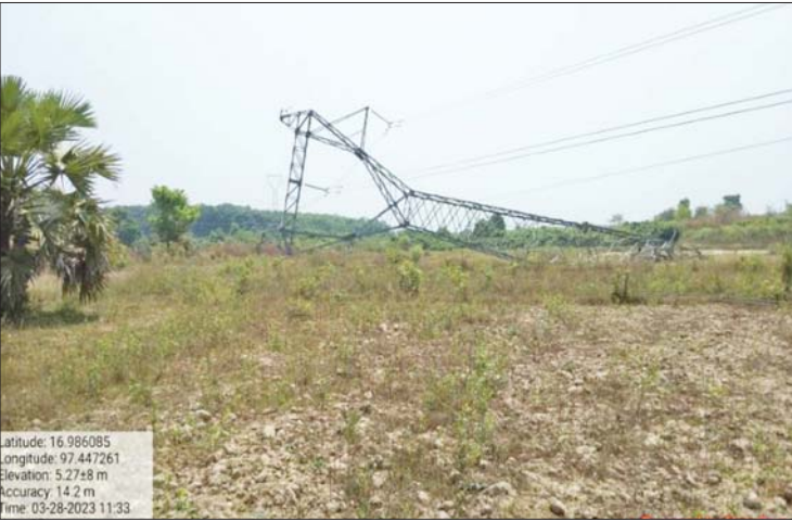
၂၃၀ ကေစီ သထုံ - မော်လမြိုင် ဓာတ်အားလိုင်း တာဝါတိုင်တစ်တိုင် မိုင်းခွဲဖျက်ဆီးခံရ၍ ပြိုလဲပျက်စီးနေပုံ။
