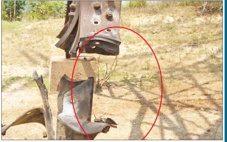
၂၃၀ ကေစီ သထုံ - မော်လမြိုင် ဓာတ်အားလိုင်း တာဝါတိုင်တစ်တိုင် မိုင်းခွဲဖျက်ဆီးခံရ၍ ခြေထောက်တစ်ချောင်း ပျက်စီးနေပုံ။
