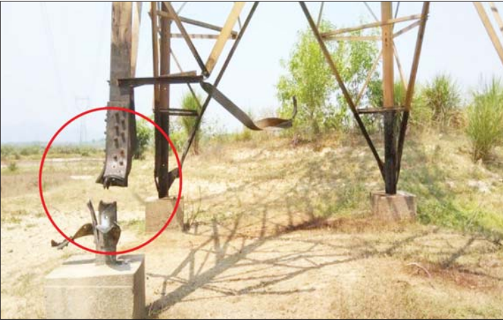
၂၃၀ ကေစီ သထုံ - မော်လမြိုင် ဓာတ်အားလိုင်း တာဝါတိုင်တစ်တိုင် မိုင်းခွဲဖျက်ဆီးခံရ၍ ခြေထောက်တစ်ချောင်း ပျက်စီးနေပုံ။
