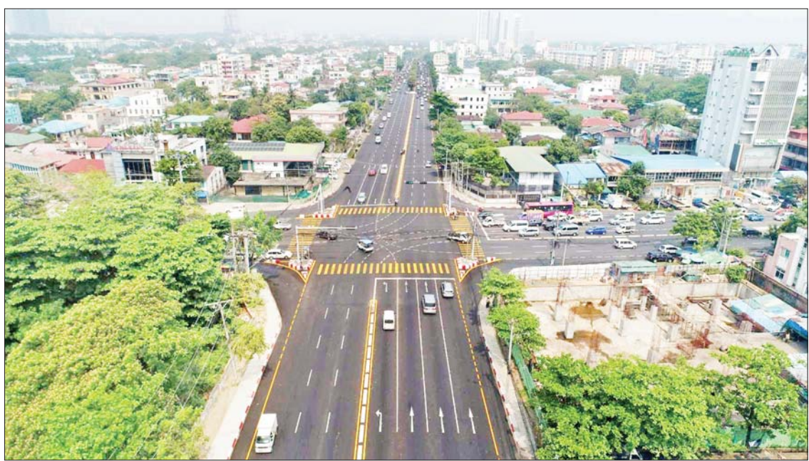
တောင်ဥက္ကလာပမြို့နယ် ဝေဇယန္တာလမ်းနှင့် သစ္စာလမ်းဆုံအား လမ်းအဆင့်မြှင့်တင်ဆောင်ရွက်ထားမှုကို တွေ့ရစဉ်။
