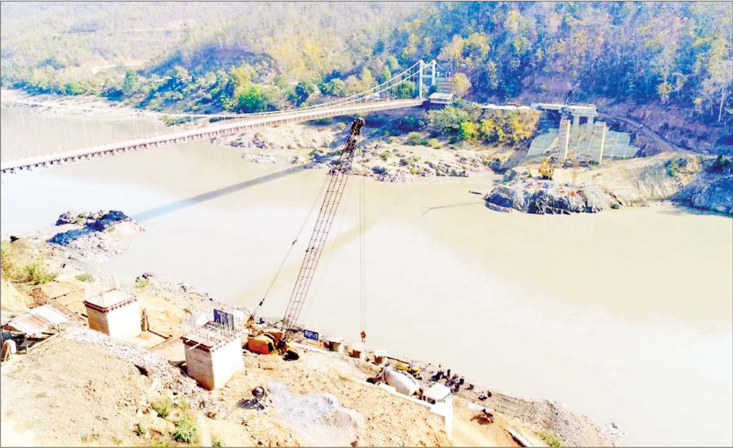
သံလွင်တံတား(တာဆန်း) တည်ဆောက်နေမှုလုပ်ငန်းခွင်ကို တွေ့ရစဉ်။
