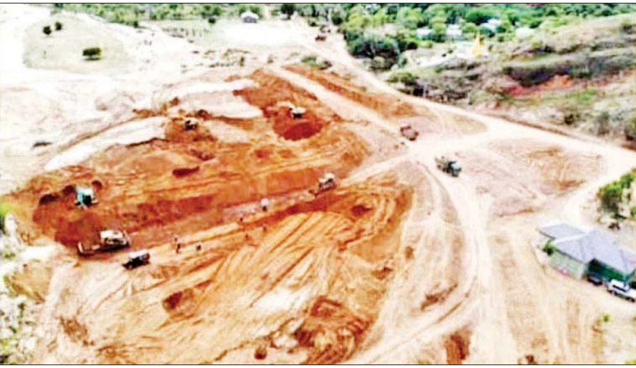
ညောင်ဦးခရိုင် ညောင်ဦးမြို့နယ် ဝါခင်းကြီးမြေအောက်တမံတည်ဆောက်နေမှုကို တွေ့ရစဉ်။
