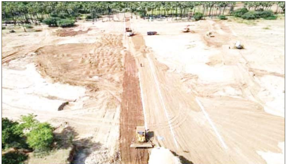
ညောင်ဦးခရိုင် ကျောက်ပန်းတောင်းမြို့နယ် စိတ္တိန်းချောင်းမြေအောက်တမံ တည်ဆောက်ခြင်းလုပ်ငန်းကို တွေ့ရစဉ်။
