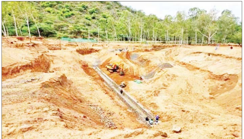
ညောင်ဦးခရိုင် ညောင်ဦးမြို့နယ် တောင်ဇင်းချောင်းမြေအောက်တမံ တည်ဆောက်ခြင်းလုပ်ငန်းကို တွေ့ရစဉ်။
