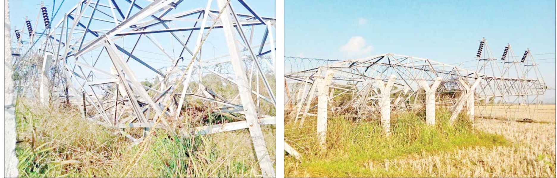
၁၃၂ ကေဗီ ဘီလူးချောင်း(၂)- တီကျစ် ဓာတ်အားလိုင်း၏ တာဝါတိုင်များ ဖောက်ခွဲဖျက်ဆီးခံရမှုကြောင့် ပြုလဲပျက်စီးခဲ့သည့် မှတ်တမ်းဓာတ်ပုံ။
