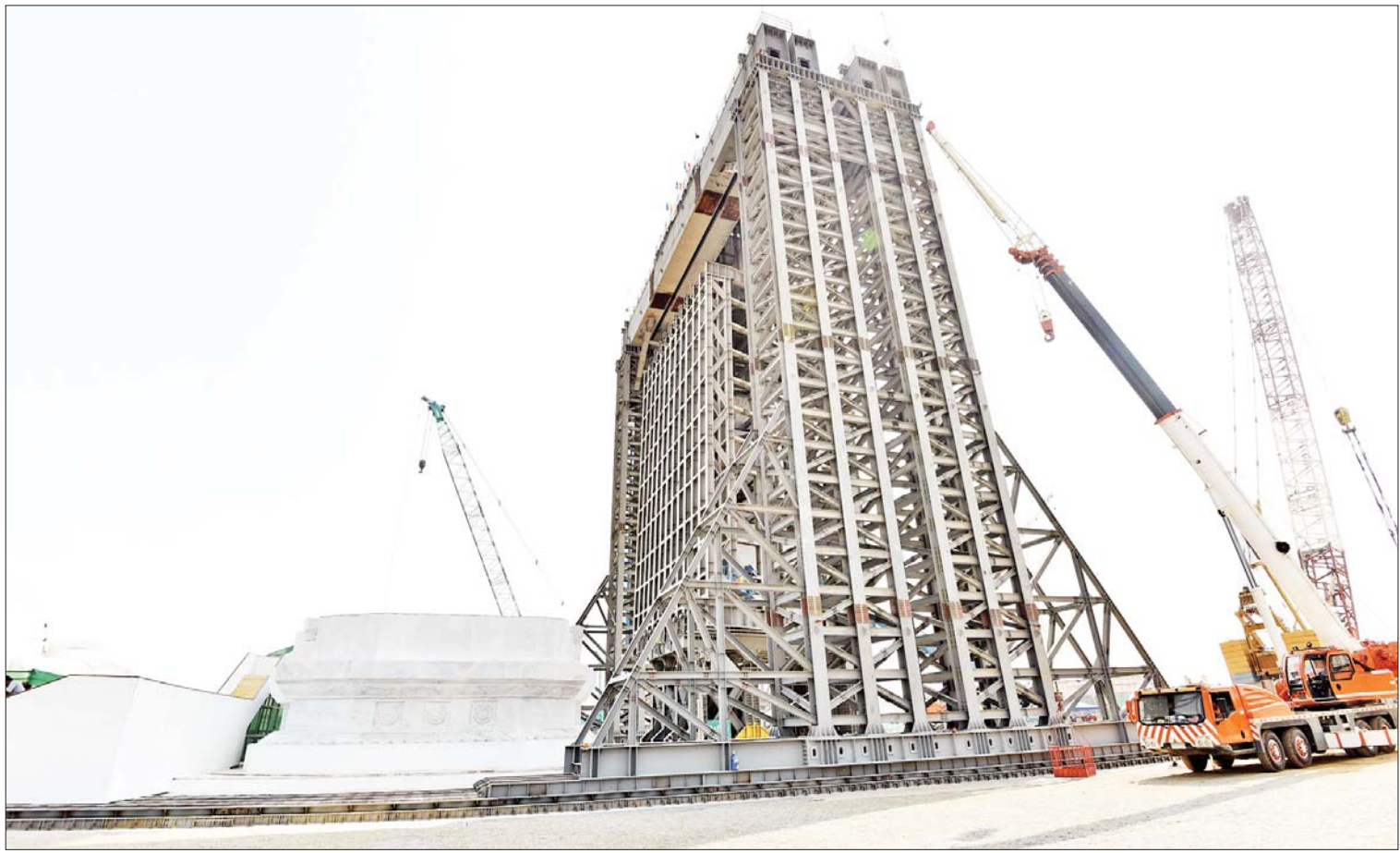
ပင့်ဆောင်ပြီးစီးသည့် မာရဝိဇယဗုဒ္ဓရုပ်ပွားတော်မြတ်ကြီး၏ အစိတ်အပိုင်းကြီးအား ရတနာပလ္လင်တော်ထက်သို့ ပင့်ဆောင်ရေးလုပ်ငန်းများကို ဆက်လက်ဆောင်ရွက်ခဲ့ရာ ဇန်နဝါရီ ၃၀ ရက် နံနက် ၁၀ နာရီ ၁၇ မိနစ်ခန့်တွင် ရတနာပလ္လင်တော်အနီးနေရာအထိ ပင့်ဆောင်ထားမှုကို ဖူးတွေ့ရစဉ်။
