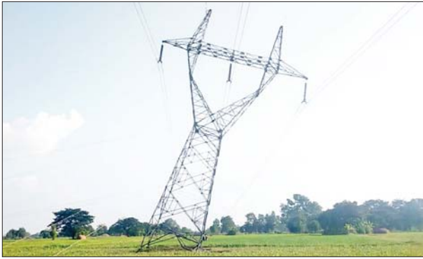
၁-၁-၂၀၂၃ ရက်တွင် ၂၃၀ ကေဗီ တောင်ငူ-သာယာကုန်းဓာတ်အားလိုင်း၊ ပဲခူးတိုင်းဒေသကြီး(အရှေ့ပိုင်း) ညောင်လေးပင်ခရိုင် ကျောက်တံခါးမြို့အနီးရှိ ဖျက်ဆီးခံရသည့် တာဝါတိုင်အား တာဝါတိုင်ပြုလဲမှုမဖြစ်စေရန် အရေးပေါ်ပြုပြင်နေပုံ။
