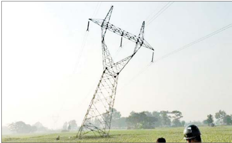
၁-၁-၂၀၂၃ ရက်တွင် ၂၃၀ ကေဗီ တောင်ငူ-သာယာကုန်း ဓာတ်အားလိုင်း၊ ပဲခူးတိုင်းဒေသကြီး (အရှေ့ပိုင်း) ညောင်လေးပင် ခရိုင် ကျောက်တံခါးမြို့အနီးရှိ ဖောက်ခွဲဖျက်ဆီးခံရသည့် တာဝါတိုင်တိုင်းစောင်းနေမှု အခြေအနေ။
