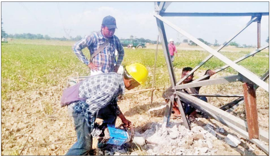
၁-၁-၂၀၂၃ ရက်တွင် ၂၃၀ ကေဗီ တောင်ငူ-သာယာကုန်း ဓာတ်အားလိုင်း၊ ပဲခူးတိုင်းဒေသကြီး (အရှေ့ပိုင်း) ညောင်လေးပင် ခရိုင် ကျောက်တံခါးမြို့အနီးရှိ ဖောက်ခွဲဖျက်ဆီးခံရသည့် တာဝါတိုင်တိုင်းစောင်းနေမှု အခြေအနေ။
