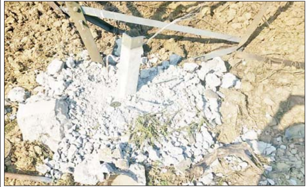
၁-၁-၂၀၂၃ ရက်တွင် ၂၃၀ ကေဗီ တောင်ငူ-သာယာကုန်းဓာတ်အားလိုင်း၊ ပဲခူးတိုင်းဒေသကြီး(အရှေ့ပိုင်း) ညောင်လေးပင်ခရိုင် ကျောက်တံခါးမြို့အနီးရှိ ဖျက်ဆီးခံရသည့် တာဝါတိုင်အား တာဝါတိုင်ပြုလဲမှုမဖြစ်စေရန် အရေးပေါ်ပြုပြင်နေပုံ။
