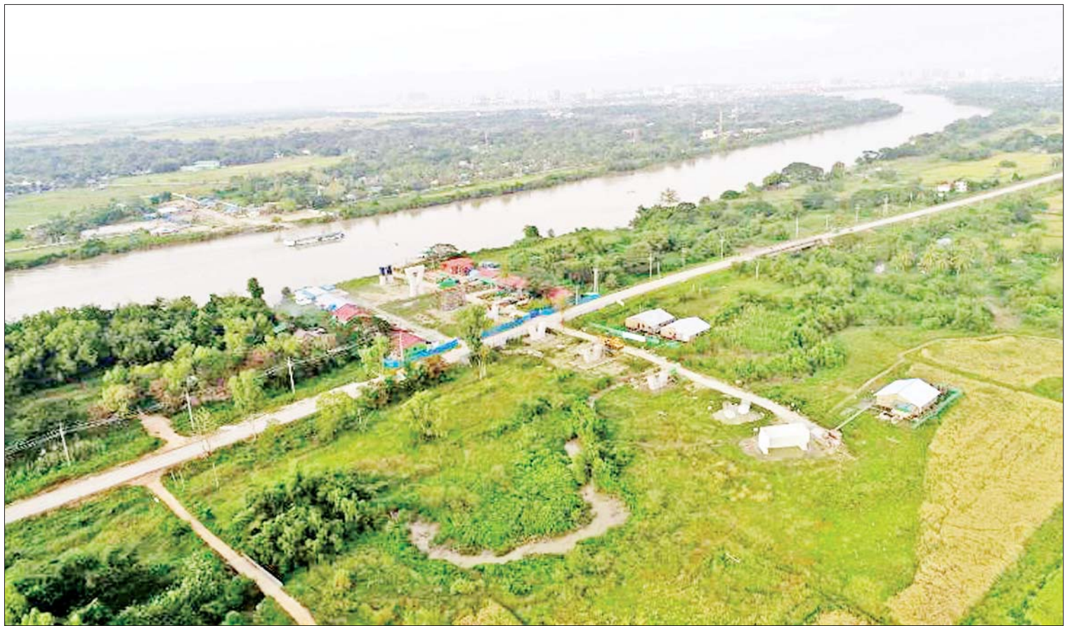
ဆိပ်ကြီးခနောင်တိုတံတား တည်ဆောက်ရေးစီမံကိန်းလုပ်ငန်းခွင်ကို တွေ့ရစဉ်။
