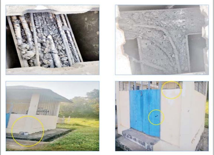
၂၃၀ ကေဗီ မြဝတီပင်မဓာတ်အားခွဲရုံ၏ Control Cable နှင့် Generator House ပျက်စီးမှုအခြေအနေ မှတ်တမ်းဓာတ်ပုံ။
