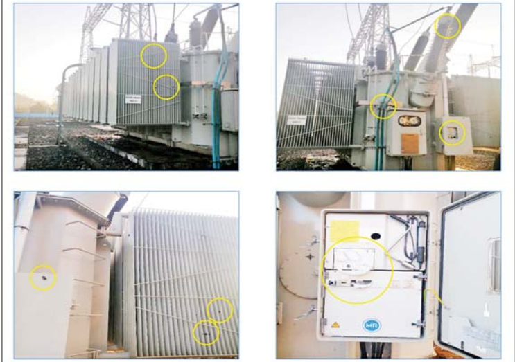
၂၃၀ ကေဗီ မြဝတီပင်မဓာတ်အားခွဲရုံ၏ Main-2 GCB၊ LA နှင့် BUS PT တို့၏ ပျက်စီးမှုအခြေအနေ မှတ်တမ်းဓာတ်ပုံ။
