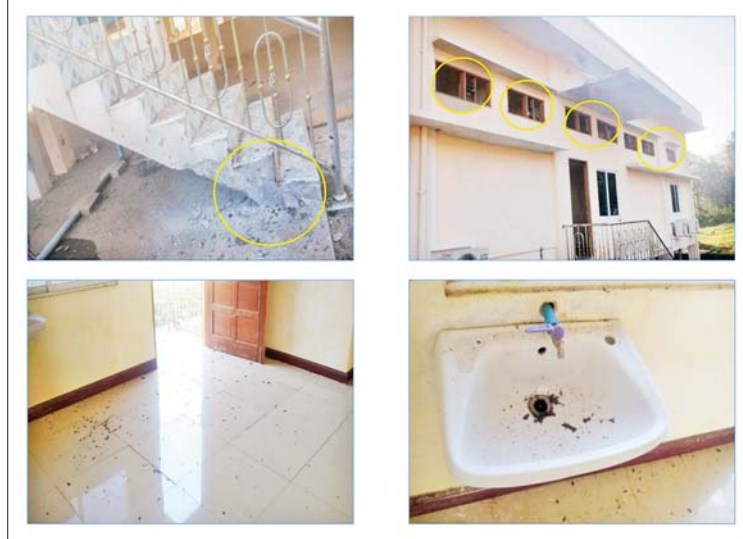
၂၃၀ ကေဗီ မြဝတီပင်မဓာတ်အားခွဲရုံ၏ Control Room ပျက်စီးမှုအခြေအနေ မှတ်တမ်းဓာတ်ပုံ။
