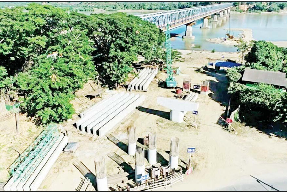
ဧရာဝတီမြစ်ကူး(ဗလမင်းထင်)တံတားအမှတ်(၂) တည်ဆောက်ရေးလုပ်ငန်းများ ဆောင်ရွက်နေစဉ်။
