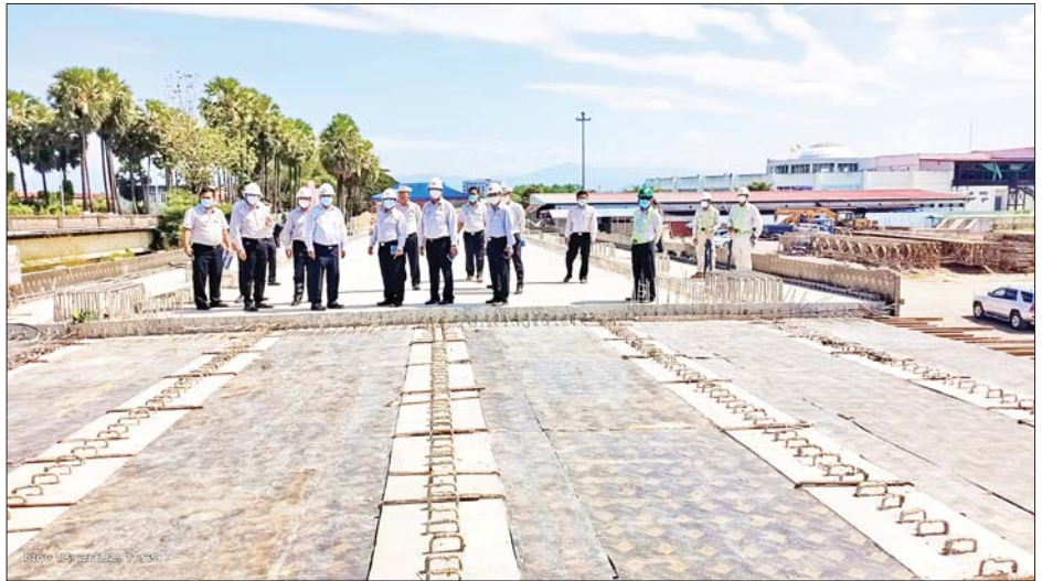
ကြောပိတ်ဆို့မှုပြဿနာ ဖြေရှင်းနိုင်မှုကြောင့် ကုန်စည်စီးဆင်းမှု မြန်ဆန်လာနိုင်ရေးအတွက်ပါ စဉ်းစားလုပ်ဆောင်ရန်လိုကြောင်း မှာကြားသည်။ ယင်းနောက် ဒုတိယဝန်ကြီးနှင့်အဖွဲ့သည် ကမြောက်ကင်းတံတားသစ် တည်ဆောက်နေမှုနှင့် တံတားချဉ်းကပ်လမ်း တည်ဆောက်နေမှုကို ထားဝယ်မြို့သို့အဝင်ဘက်အခြမ်း၊ လောင်းလုံးမြို့နှင့် မောင်းမကန်သို့ခွဲထွက်သည့် အပိုင်းပတ်နေရာများသို့ ကြည့်ရှုစစ်ဆေးပြီး လိုအပ်သည်များ မှာကြားခဲ့ ကြောင်း သိရသည်။ သတင်းစဉ်
