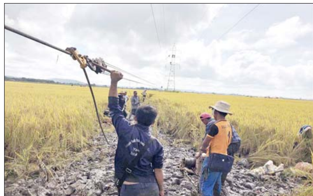
တာဝါတိုင်အမှတ်(၁၁၉)နှင့် (၁၂၀) ကြား လက်နက်ကျည်ထိမှန်မှုကြောင့် ACSR Conductor ကြိုးပျက်ကျခြင်းအား ပြန်လည်ပြုပြင်နေသည့် မှတ်တမ်းဓာတ်ပုံ။
