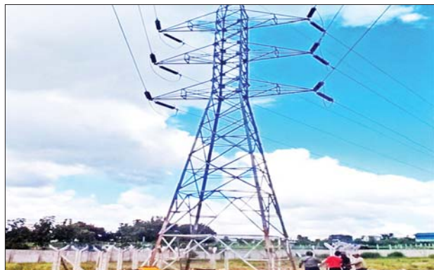
၁၃၂ ကေစီ ဘီလူးချောင်း(၂)-တီကျပ် နှစ်ထပ်ဓာတ်အားလိုင်း တာဝါတိုင်အမှတ်(၁၃၀) ပြန်လည်တည်ဆောက်ပြီးစီးသည့် မှတ်တမ်းဓာတ်ပုံ။
