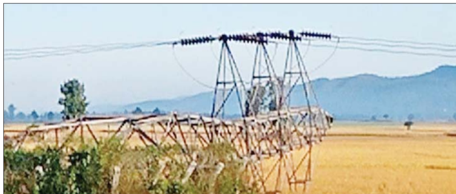
၁၃၂ ကေစီ ဘီလူးချောင်း(၂)-တီကျပ် နှစ်ထပ်ဓာတ်အားလိုင်း တာဝါတိုင်အမှတ်(၁၁၁) ဖောက်ခွဲဖျက်ဆီးခံရသည့် မှတ်တမ်းဓာတ်ပုံ။
