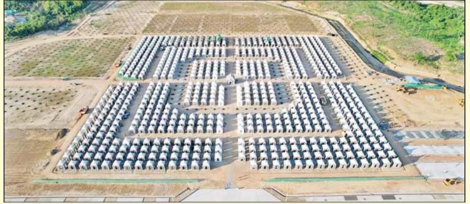
၁၁ လပိုင်း ၂၀၂၂ တွင် ကျောက်စာစေတီတည်ဆောက်ခြင်းလုပ်ငန်း ဆောင်ရွက်ပြီးစီးမှု။
