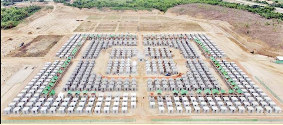
၈ လပိုင်း ၂၀၂၂ တွင် ကျောက်စာစေတီတည်ဆောက်ခြင်းလုပ်ငန်း ဆောင်ရွက်ပြီးစီးမှု။
