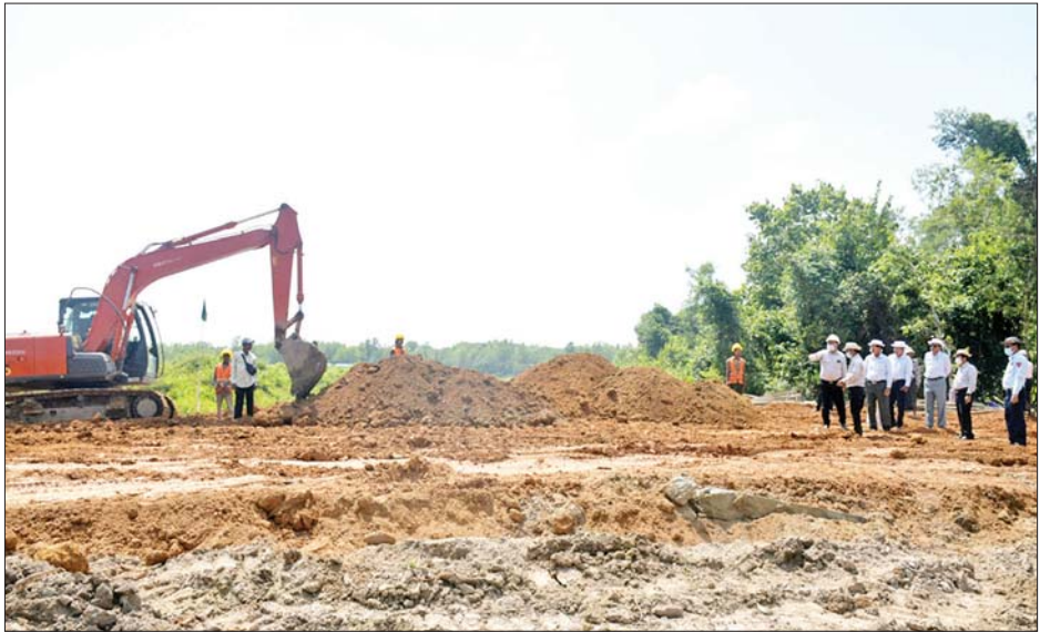
ဆောင်ရွက်နေမှု၊ ညောင်နှစ်ပင် အထူးဇုန် ဟင်းသီးဟင်းရွက် လက်ကားဈေး တည်ဆောက်ရန် စက်ယန္တရားကြီးများ၊ ဝန်ထမ်း တို့ကို ကြည့်ရှုစစ်ဆေးသည်။ တိုင်းဒေသကြီး (ပြန်/ဆက်)
