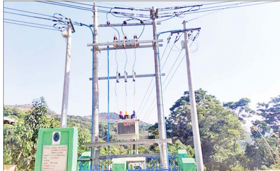
ပင်လုံမြို့ ကိုးနဝင်းစေတီတော်မြတ်ကြီးမှ ဆန်းကျေးရွာအထိ လျှပ်စစ်မီးသွယ်တန်းခြင်းလုပ်ငန်း ဆောင်ရွက်ထားမှုကို တွေ့ရစဉ်။
