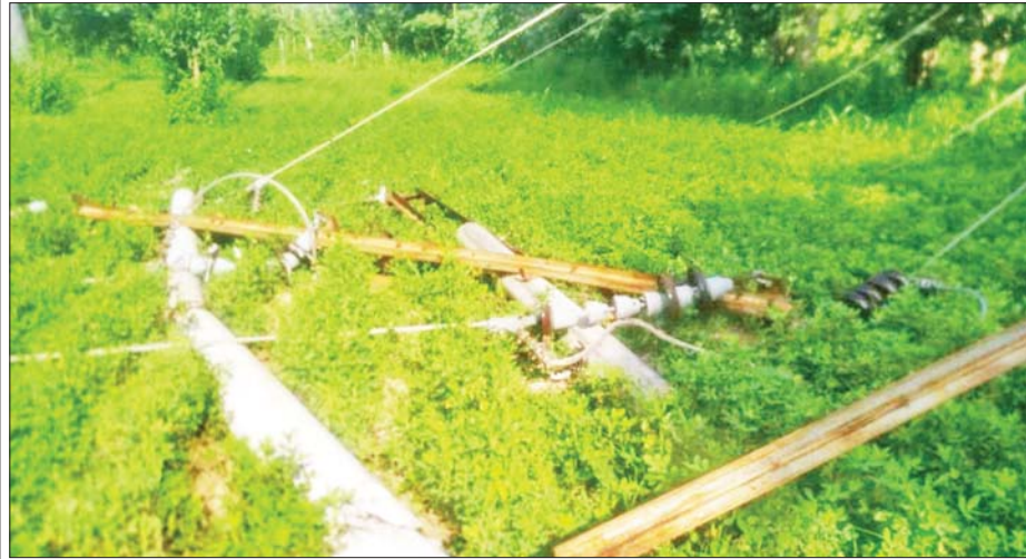
၆၆ ကေစီ ကျွန်းချောင်း-မြိုင်(၂) ဓာတ်အားလိုင်း တိုင်အမှတ်(၄၂၆) အား ဖျက်ဆီးထားမှုကို တွေ့ရစဉ်။
