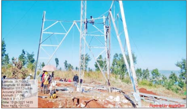
၂၃၀ ကေဗီ ဘီလူးချောင်း(၂)-ရွှေမြို့ ဓာတ်အားလိုင်း တာဝါတိုင်အမှတ် (၁၂၂) ပြန်လည်ပြုပြင်နေမှု မှတ်တမ်းဓာတ်ပုံ။
