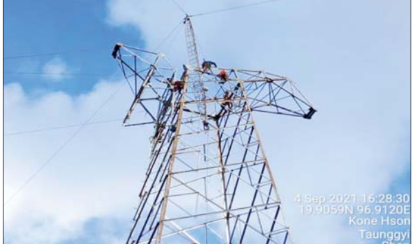
၂၃၀ ကေဗီ ဘီလူးချောင်း(၂)-ရွှေမြို့ ဓာတ်အားလိုင်း တာဝါတိုင်အမှတ် (၁၆၅) တိုင်ကျိုးပြုပြင်နေမှု မှတ်တမ်းဓာတ်ပုံ။
