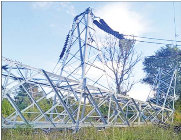
၂၃၀ ကေဗီ ဘီလူးချောင်း(၂)-ရွှေမြို့ ဓာတ်အားလိုင်း တာဝါတိုင်အမှတ် (၉၈) ပြိုလဲပျက်စီးနေမှု မှတ်တမ်းဓာတ်ပုံ။
