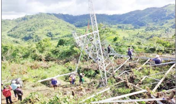
၂၃၀ ကေဗီ ဘီလူးချောင်း(၂)-ရွှေမြို့ ဓာတ်အားလိုင်း တာဝါတိုင်အမှတ် (၁၆၄) တိုင်ကျိုးပြုပြင်နေမှု မှတ်တမ်းဓာတ်ပုံ။
