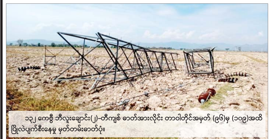
၁၃၂ ကေစီ ဘီလူးချောင်း(၂)-တီကျစ် ဓာတ်အားလိုင်း တာဝါတိုင်အမှတ် (၉၆)မှ (၁၀၉)အထိ ပြိုလဲပျက်စီးနေမှု မှတ်တမ်းဓာတ်ပုံ။
