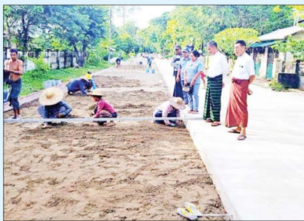
ဧရာဝတီတိုင်းဒေသကြီး လပွတ္တာမြို့နယ်၌ မြို့နယ်စည်ပင် သာယာရေးအဖွဲ့၏ ၂၀၂၂-၂၀၂၃ ဘဏ္ဍာနှစ် ငွေလုံးငွေရင်းဖြင့် အကောင်အထည်ဖော် ဆောင်ရွက်လျက်ရှိသော အမှတ်(၅)ရပ်ကွက် စိန်ရတုလမ်း ကွန်ကရစ်ခင်းခြင်းလုပ်ငန်းကို စက်တင်ဘာ ၂၁ ရက် နံနက်ပိုင်းတွင် တာဝန်ရှိသူများက ကွင်းဆင်းစစ်ဆေးစဉ်။
