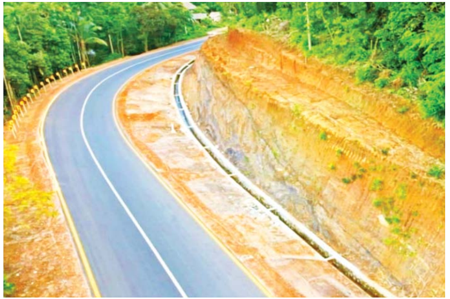
ထားဝယ်-မြိတ်-ကျောသောင်း ပြည်ထောင်စုလမ်းမကြီး (ပလောက်-ပလောက်-မြိတ်အပိုင်း)ကို တွေ့ရစဉ်။
