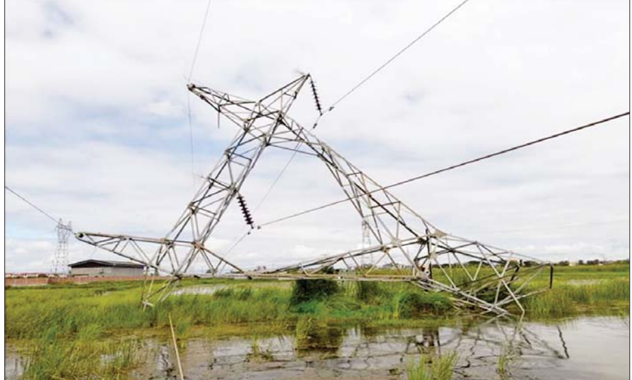
၁၃၂ ကေဗီ ရွှေစာရ်-တံခွန်တိုင် ဓာတ်အားလိုင်းမှ ပြုလဲပျက်စီးနေသည့် တာဝါတိုင် အမှတ်(၄၅)၏ မှတ်တမ်းဓာတ်ပုံ။
