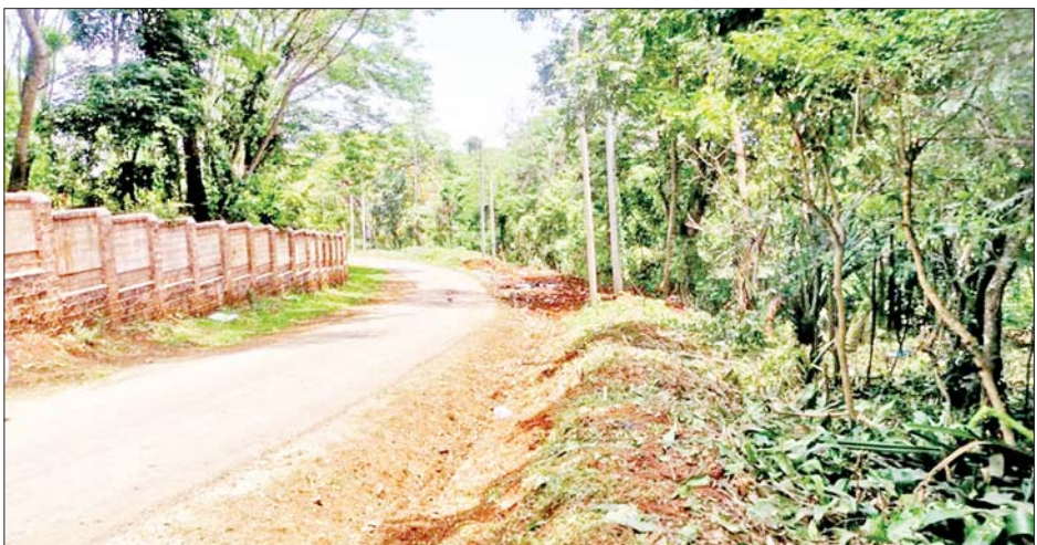
ကျောက်မဲမြို့၌ သန့်ရှင်းရေးဆောင်ရွက်ပြီးစီးမှုကို တွေ့ရစဉ်။
