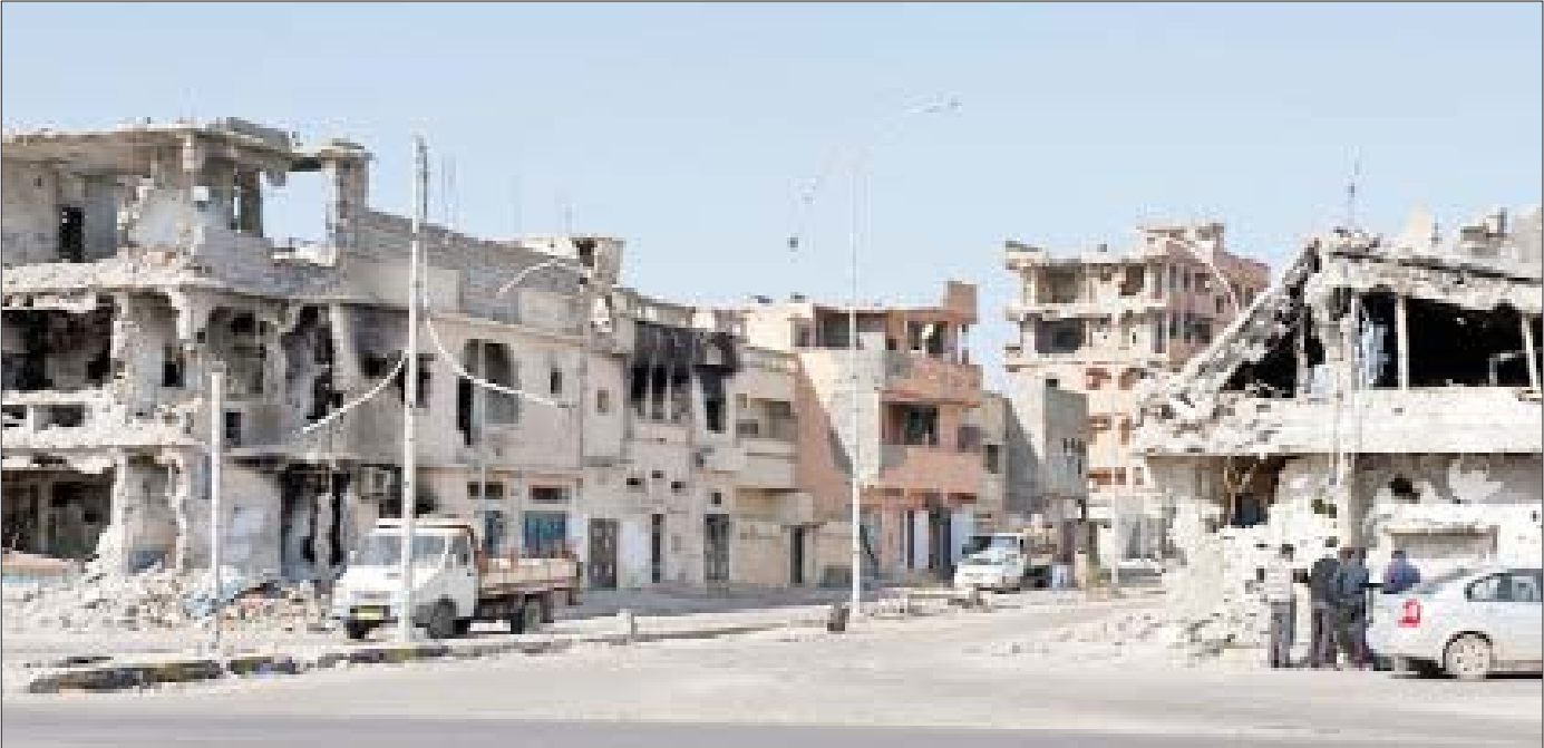
လစ်ဗျားနိုင်ငံ၌ လေကြောင်းတိုက်ခိုက်ခံရမှုကြောင့် အဆောက်အအုံများပျက်စီးဆုံးရှုံးမှုကို တွေ့ရစဉ်။
