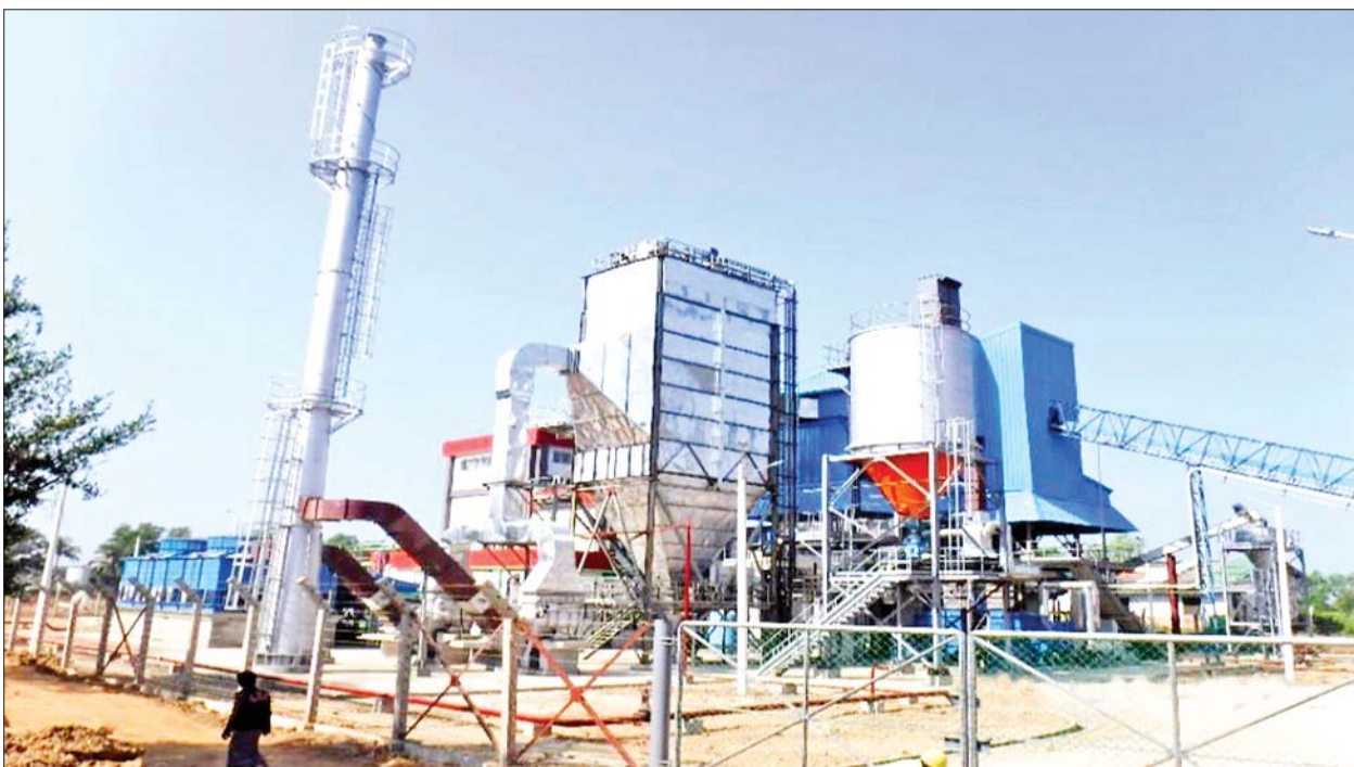
မြောင်းမြမြို့နယ်ရှိ ၁ ဒသမ ၈ မဂ္ဂါဝပ် စပါးခွံမှ လျှပ်စစ်ထုတ်လုပ်ရေးစက်ရုံ (တည်ဆောက်ဆဲ)ကို တွေ့ရစဉ်။
