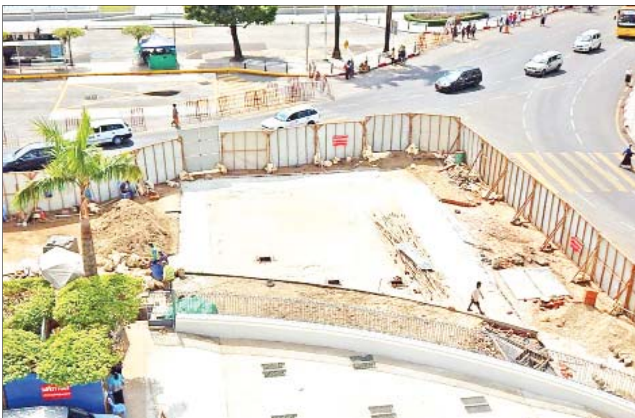
ရန်ကုန်မြို့၌ ပထမဦးဆုံးတည်ဆောက်နေသော ရေဂါလန် တစ်သိန်းဆုံ ရေစုကန် တည်ဆောက်နေမှုကို တွေ့ရစဉ်။
