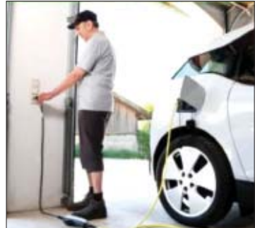
Wall-mounted/ Wallbox Charger ($310.00 - $330.00) နိုင်ငံခြား၌ အိမ်တွင်း EV အားသွင်းနေခြင်း
