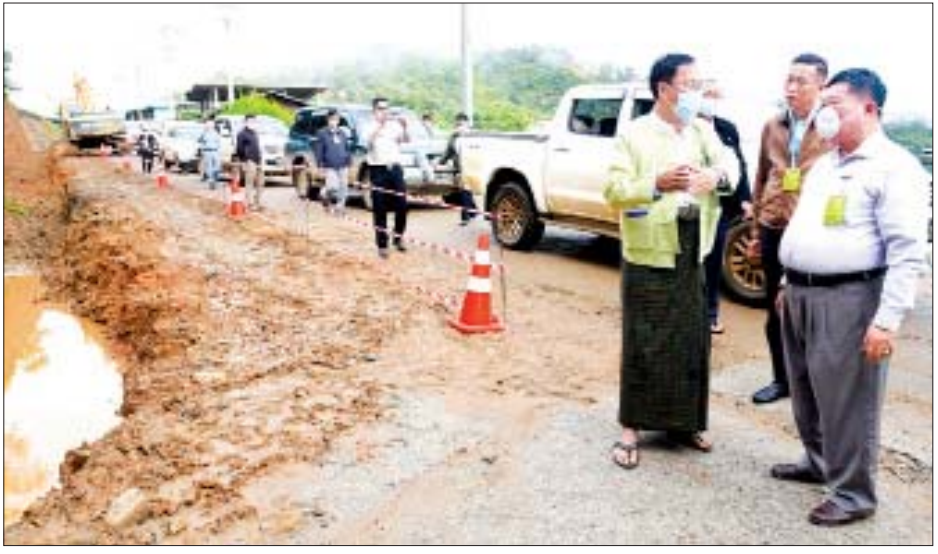
နေသာ မြေထိန်းနံရံ ပေ (၄၀၀x၁၀x၂) ဆောင်ရွက် (၃၀x၂၀) တည်ဆောက်နေမှုတို့ကို ကြည့်ရှုစစ်ဆေး နေမှုများနှင့် ရွှေမော်ဖုကုမ္မဏီမှ တာဝန်ယူဆောင်ရွက် ခဲ့ကြောင်း သိရသည်။ နေသာ We Love Matman View Point ပေ မောင်မောင်သန်း (တောင်ကြီး)
