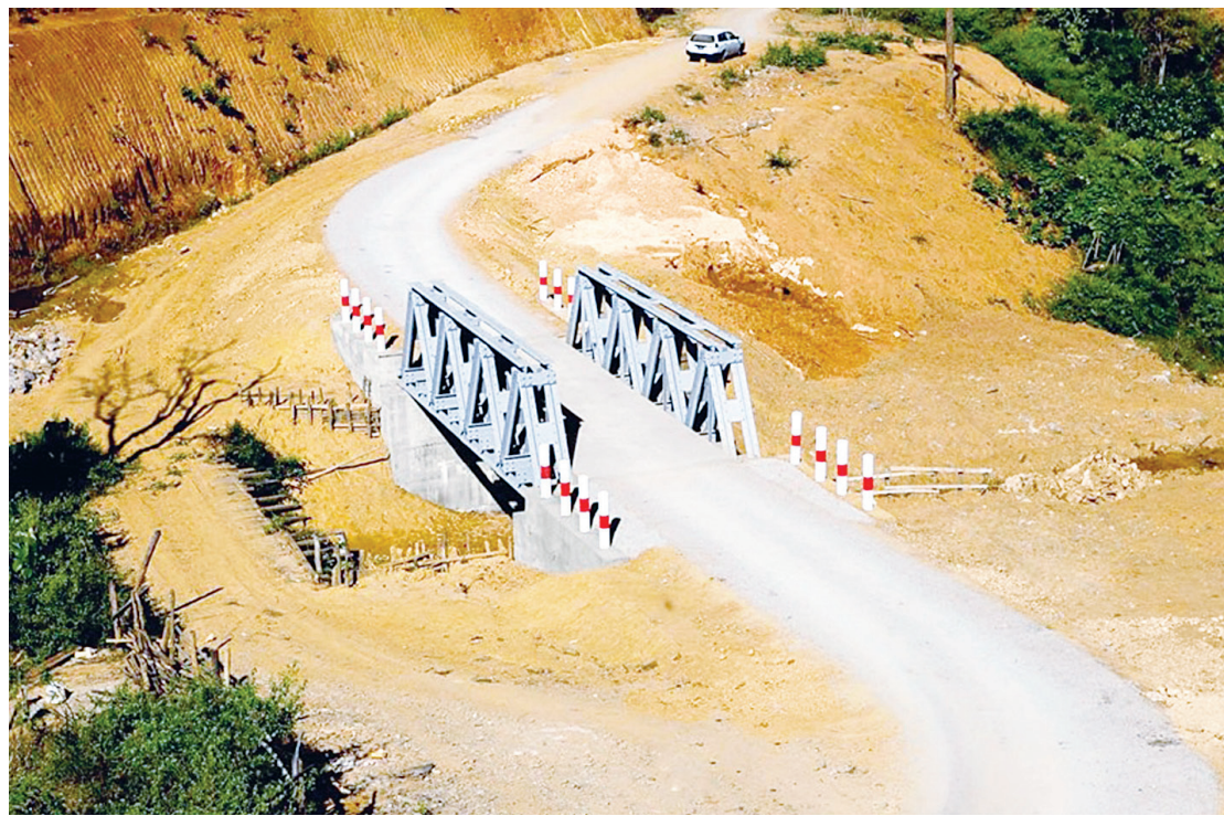
ကယားပြည်နယ် ရှားတောမြို့နယ်တွင် တည်ဆောက်ထားသော သရီးဒါး-ဒေါဝယ်ရောလမ်းပေါ်ရှိ CH သံပေါင်တံတားကို တွေ့ရစဉ်။
