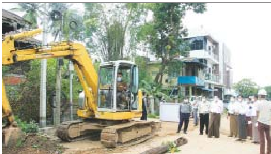
(စိန်သရဖူဂိုဒေါင်လမ်း) ကွန်ကရစ်ခင်းခြင်းလုပ်ငန်း စတင်ဆောင်ရွက်နေမှု အခြေအနေကိုလည်းကောင်း၊ ခရိုင်ပညာရေးမှူးရုံးလမ်း(ဗိုလ်အောင်ကျော်လမ်း)
