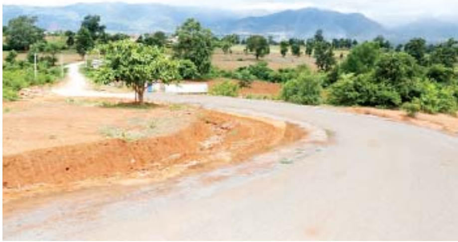
ပင်းတယမြို့နယ် ရှောက်ချို - ကုန်းသာ - တာတိုင် နှစ်မိုင်ကတ္တရာထပ်ပိုးလွှာလုပ်ငန်း ဆောင်ရွက်ပြီးစီးမှုကို တွေ့မြင်ရစဉ်။
