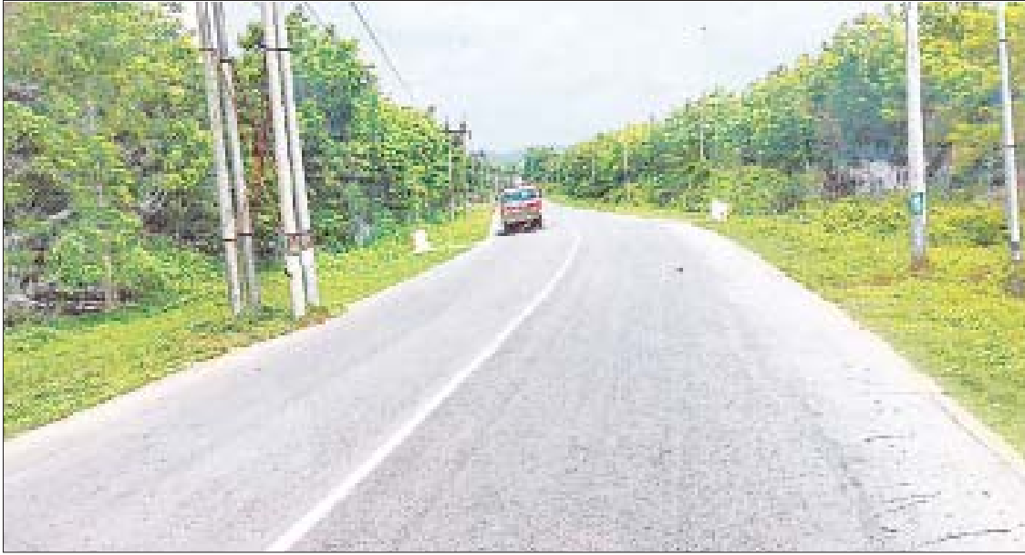
ရွှေသံလွင်ကုမ္ပဏီမှ BOT စနစ်ဖြင့် ဆောင်ရွက်ထားသော ဘုရားကြီး-စစ်တောင်း-ကျိုက်ထို-သထုံ-မော်လမြိုင် အဝေးပြေး လမ်းမကြီးကို တွေ့ရစဉ်။
