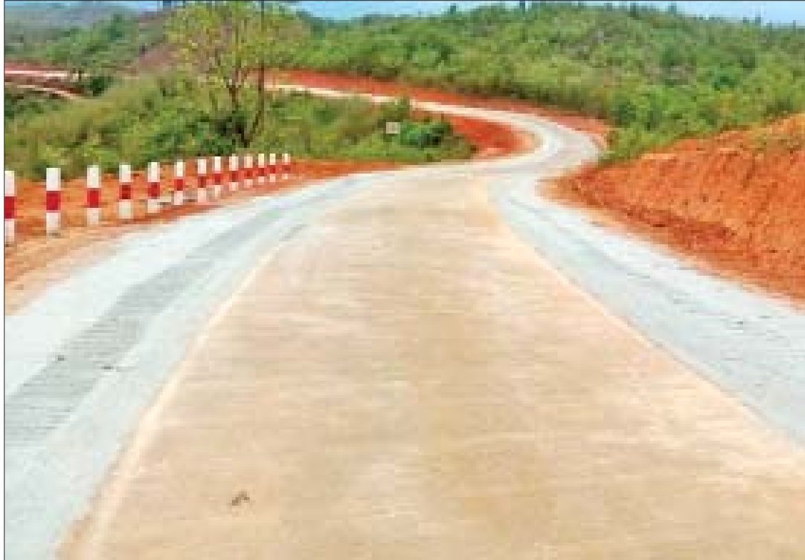
ကျိုင်းတုံခရိုင် ကျိုင်းတုံမြို့နယ် နောင်ငင်း - ဝမ်ဆိုင် (လွယ်) ကို ဆက်သွယ်ထားသည့် ကွန်ကရစ်လမ်းကို တွေ့ရစဉ်။
