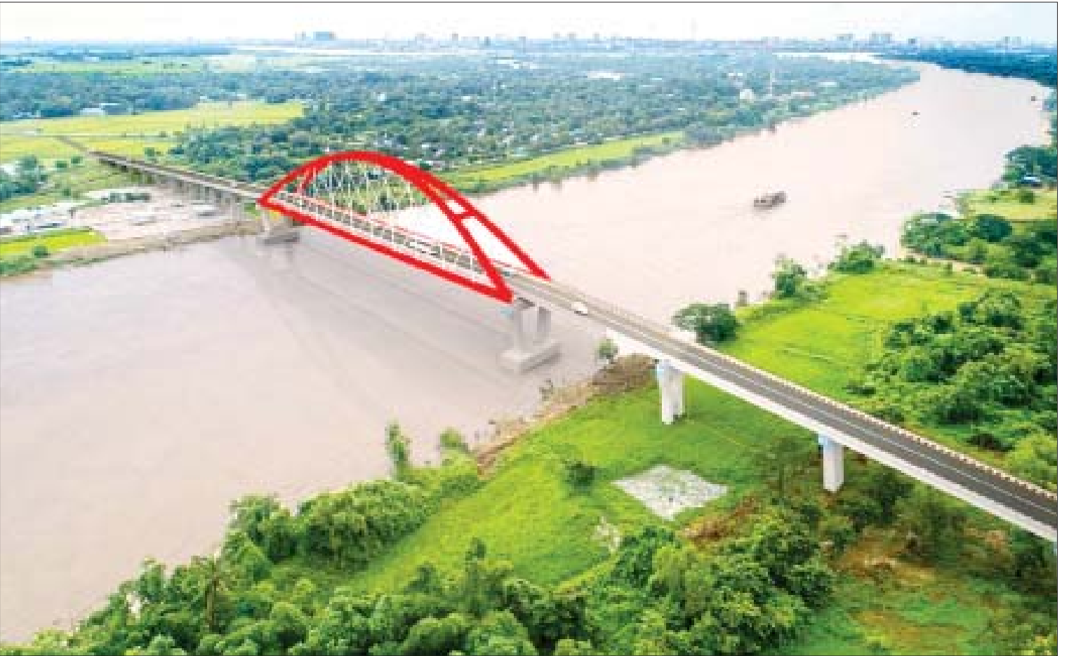
ဆိပ်ကြီးခနောင်တိုတံတား တည်ဆောက်ပြီးစီးပါက တွေ့မြင်ရမည့်ပုံစံ။
