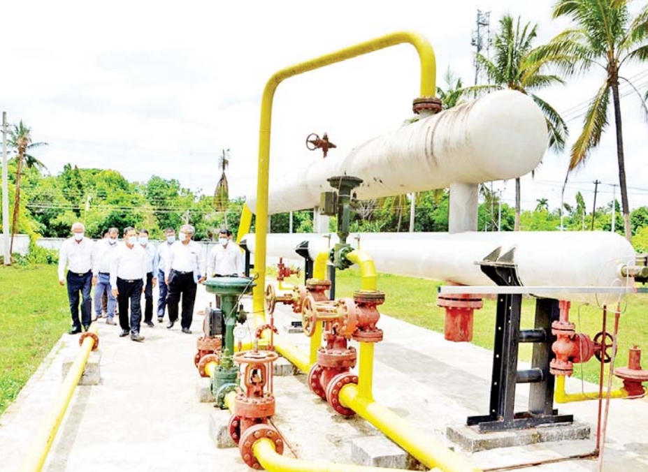
တည်ဆောက်နေသည့် စီမံကိန်းလုပ်ငန်းနေရာများ၊ ပိုက်စင်နှင့် ဂိုဒေါင်များကို လှည့်လည်ကြည့်ရှုစစ်ဆေး ရေလုံသင်္ဘောကျင်း(Dry Dock)၊ ပစ္စည်းစီမံဌာန သည်။
