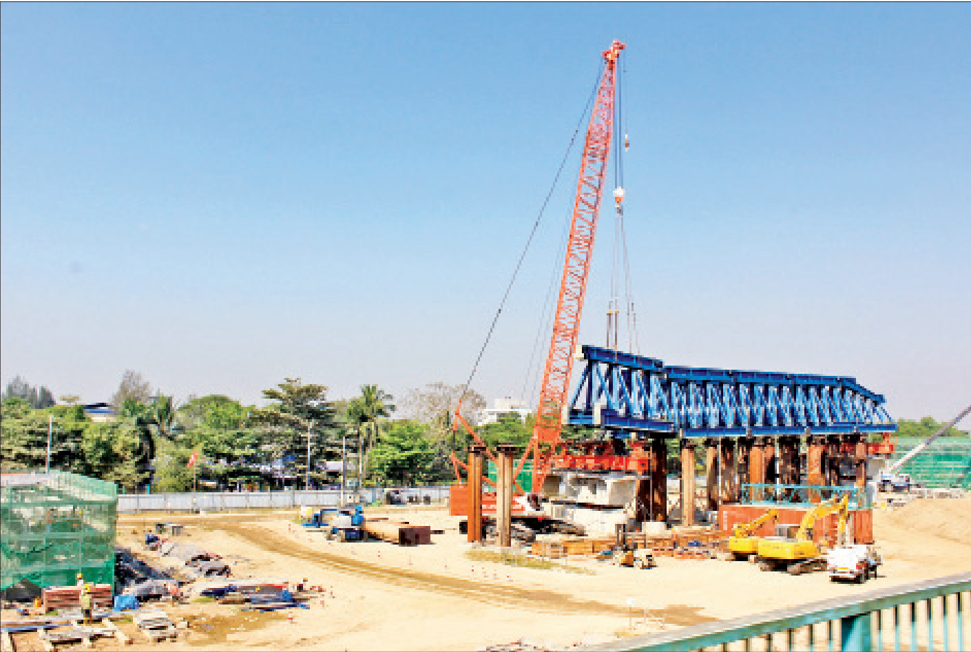
ပဲခူးမြစ်ကူးတံတား(သန်လျင်တံတား အမှတ်-၃) ရေလယ်ပင်မတံတားအတွက် ဘိုးပိုင်လုပ်ငန်းများဆောင်ရွက်နေမှုကို တွေ့ရစဉ်။
