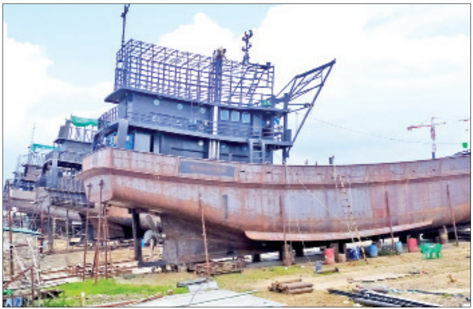
ဒဂုံဆိပ်ကမ်းသင်္ဘောကျင်း၌ သင်္ဘောများတည်ဆောက်နေမှုကို တွေ့ရစဉ်။
