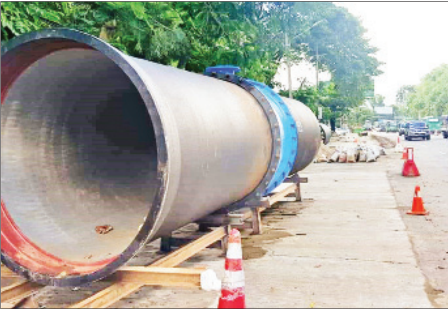
ရန်ကုန်-ပြည်လမ်းတစ်လျှောက်ဆောင်ရွက်နေသော ပိုက်လုံးအစားထိုးလဲလှယ်ခြင်းလုပ်ငန်းကို တွေ့ရစဉ်။
