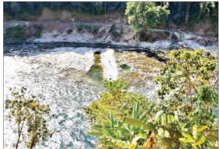
မေခမြစ်ကူး ရီဒမ်းတံတားသစ် တည်ဆောက်မည့်နေရာကို တွေ့ရစဉ်။
