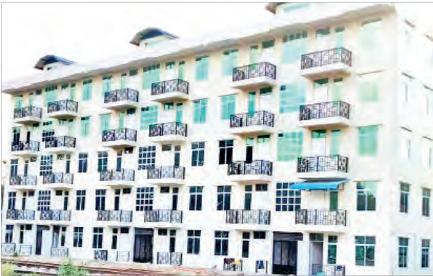
အင်းစိန်မြို့နယ် လှိုင်မီးရထားဝင်းအတွင်းရှိ ခြောက်ခန်းတွဲငါးထပ်တိုက် အထပ်မြင့်အဆောက်အအုံဆောက်လုပ်ပြီးစီးနေမှုကို တွေ့ရစဉ်။
