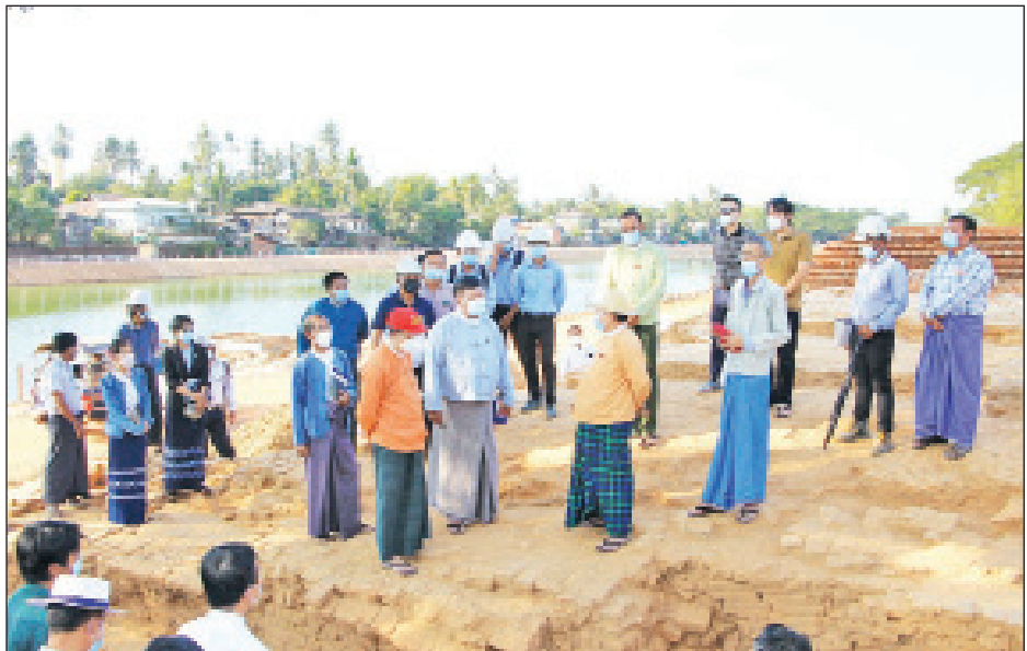
သာ တွေ့ရှိရသည့်အတွက် သိန္နီတံခါးပေါက်၏ အထောက် အထားများ ပျောက်ဆုံးလျက်ရှိနေခဲ့သည်။ ယခု၂၀၁၉-၂၀၂၀ ဘဏ္ဍာနှစ်တွင် တူးဖော်မှုကုန်း အမှတ်-၄ (BGO-4)ကို တူးဖော်သုတေသနပြုသည့်အခါ ကျင်းကွက်အမှတ်T40မှ T45အတွင်း တံခါးပေါက်ပြအိုး နှစ်လုံးနှင့် မြို့ဝင်ပေါက်ဟုယူဆရသည့် အဆောက်အအုံ အကြွင်းအကျန်များကို တူးဖော်တွေ့ရှိကြောင်း သိရသည်။ တင်စိုး(ပဲခူး)
