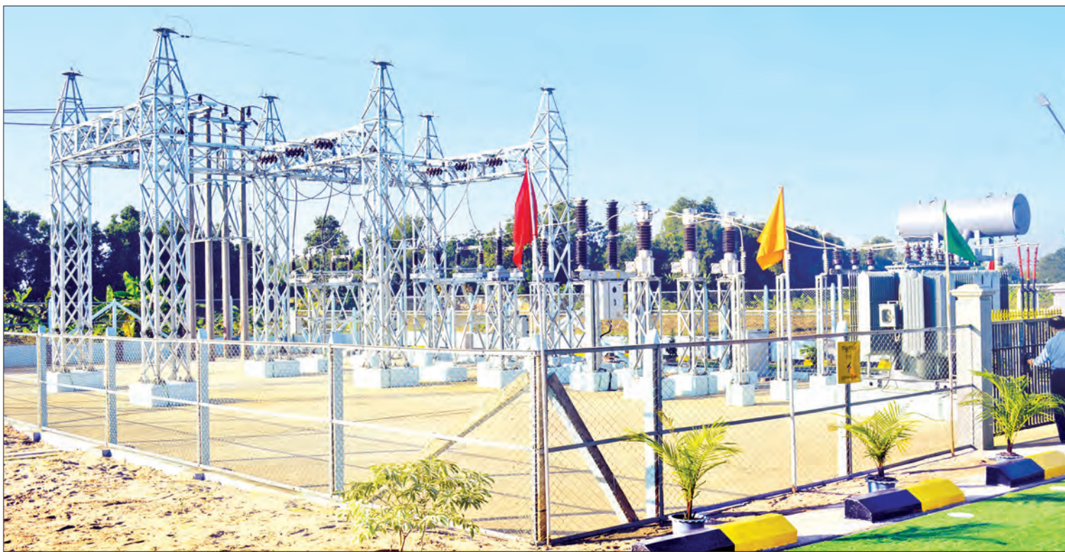
၃၁/၁၁ ကေဇီ(၅)အမိဇီအေ ဂျိုးဖြူဓာတ်အားခွဲရုံကို တွေ့ရစဉ်။
