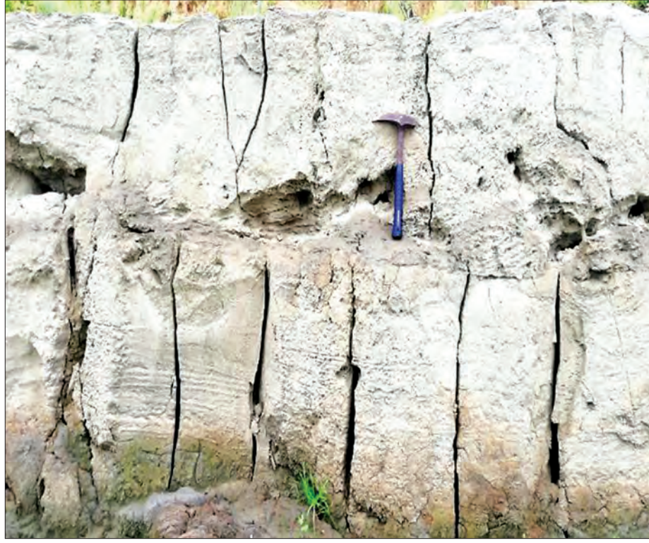
မြေသားထုအတွင်း တင်းမာဆန့်ထွက်နိုင်အား (Tensile Stress) များဖြစ်ပေါ်ကာ ဒေါင်လိုက် (Vertical Fissures) မြေလွှာအက်ကွဲမှုများ ဖြစ်ပေါ်နေစဉ်။
