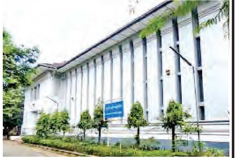
၁၉၂၇ ခုနှစ်တွင် ဆောက်လုပ်ခဲ့သည့် အလှူရှင် “ရောင်းဗဟာဒူး ရာမနုဿ ရဲဒီးယား”၏ ရန်ကုန်တက္ကသိုလ် စာကြည့်တိုက် အဆောက်အအုံကို တွေ့ရစဉ်။
